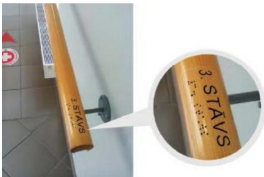
Рис. 1.3 – Маркування поручня шрифтом Брайля для позначення номера поверху
